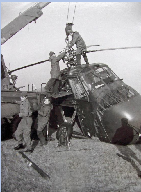
...und per Autokran abtransportiert, anschließend fachmännisch repariert, so dass man heute nichts mehr von den Schäden sieht 😊 ...
